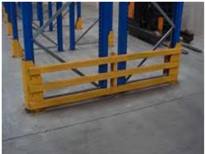
Fig. 16. Modelos de protetor frontal de coluna e protetor lateral duplo
