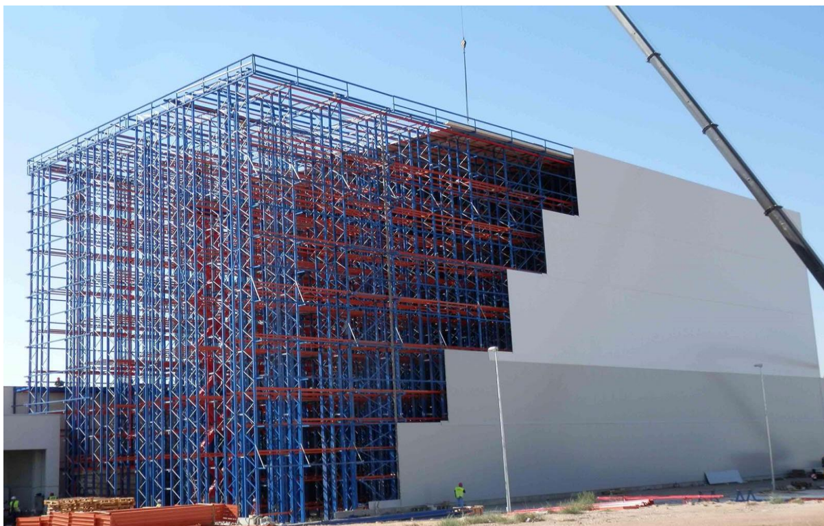
Fig. 21. Estrutura de armazenagem porta-paletes seletivo autoportante
